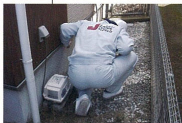
■ 基礎のひび割れ、劣化、欠損
