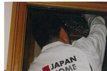
■ 小屋裏の劣化状況の確認
